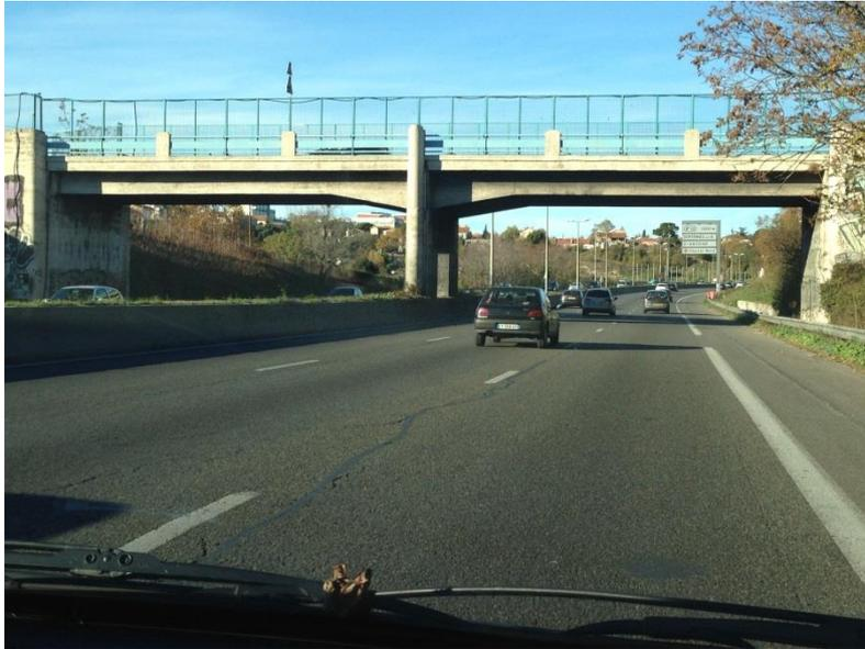
Figure 42- L'architecture de l'autoroute : les « ponts Schùhl », ouvrages d'art combinant unicité et sérialité réalisés sur le premier tronçon de l'autoroute A7 en 1950.
