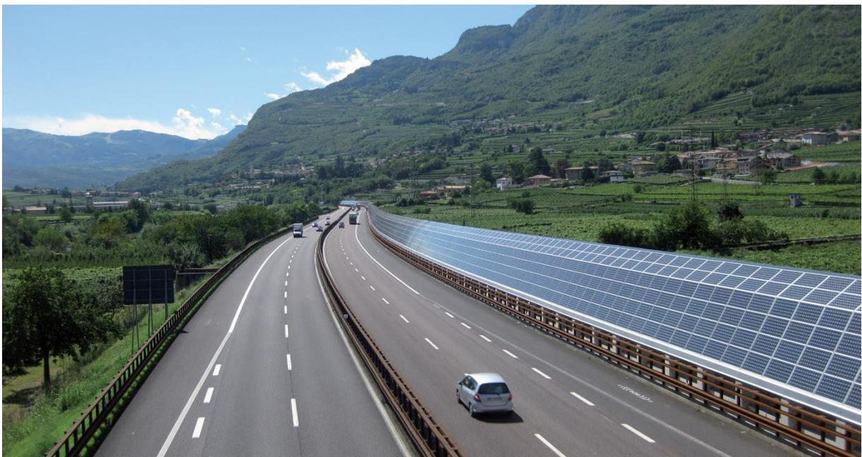
*Figure 152 - Capteurs photovoltaïques intégrés dans la structure des barrières acoustiques à Isera le long de l'A22 en Italie. Source : Costa & Duiella, 2010*
