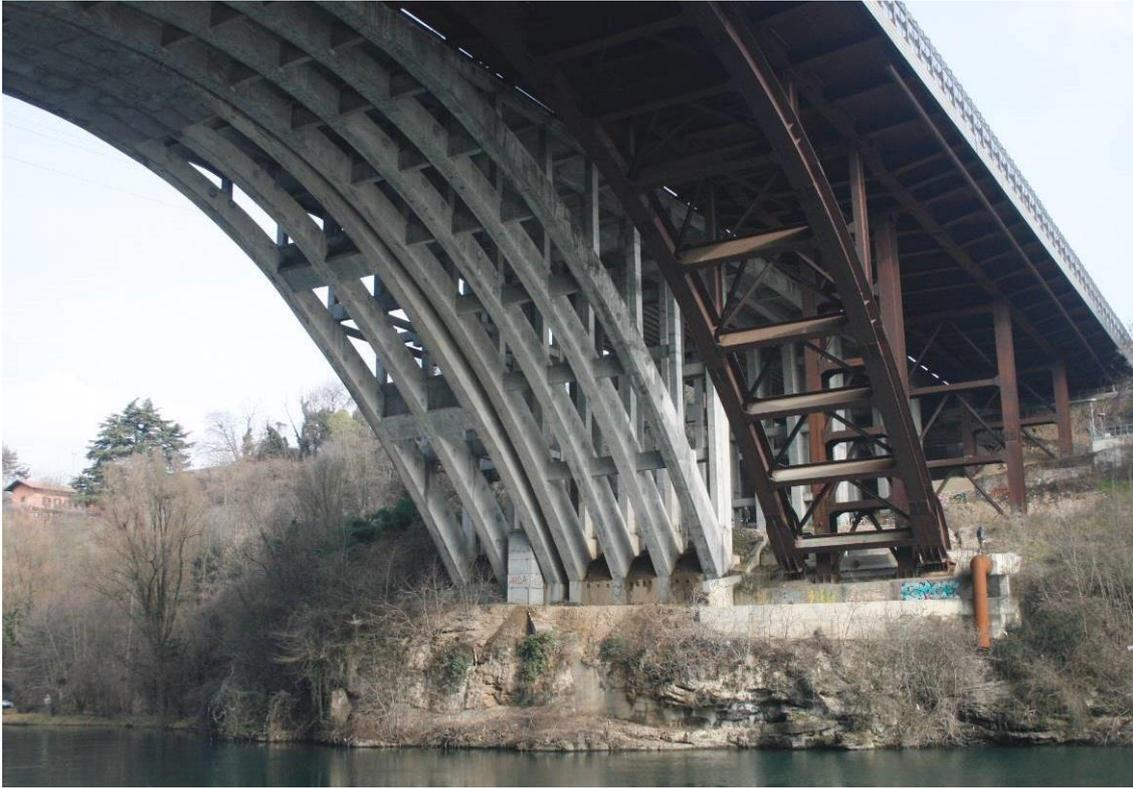
*Figure 7- Héritages : pont autoroutier sur le fleuve Adda entre Milan et Bergame. La photo montre les trois différentes générations d'autoroutes. En regardant de droite à gauche, on observe le premier ouvrage métallique de 1928, l'élargissement en deux fois-deux-voies par l'arcade en béton réalisé dans les années 1960 et enfin le dernier agrandissement de 2012. G. Salvia, 2016.*
